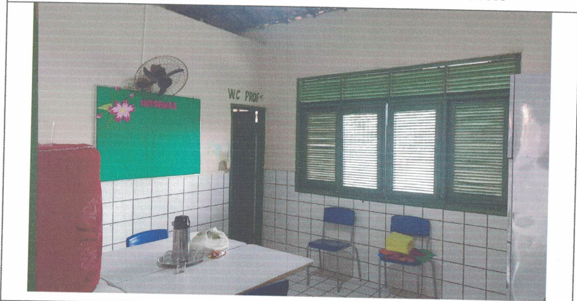
Sala dos Professores I – Local em que será instalado forro em PVC
