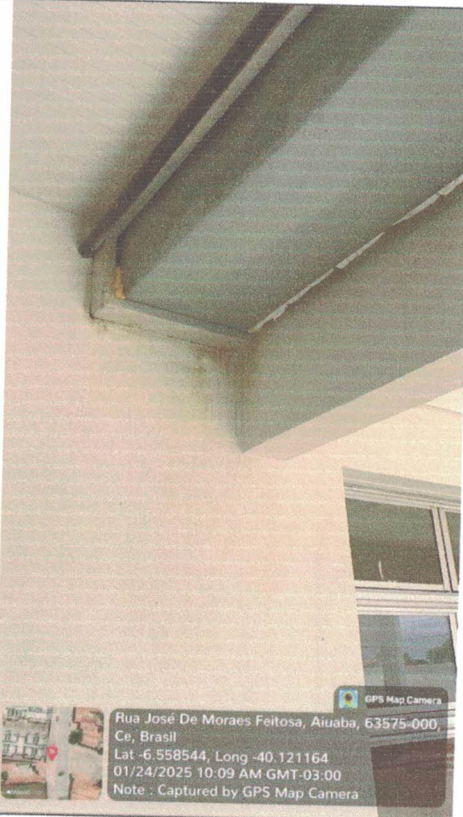
Calha metálica com desgaste aparente no CEI Professora Sirlene Maria do Nascimento
