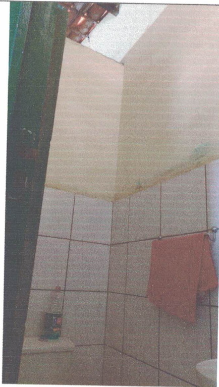
WC Professores – Local em que será instalado forro em PVC
