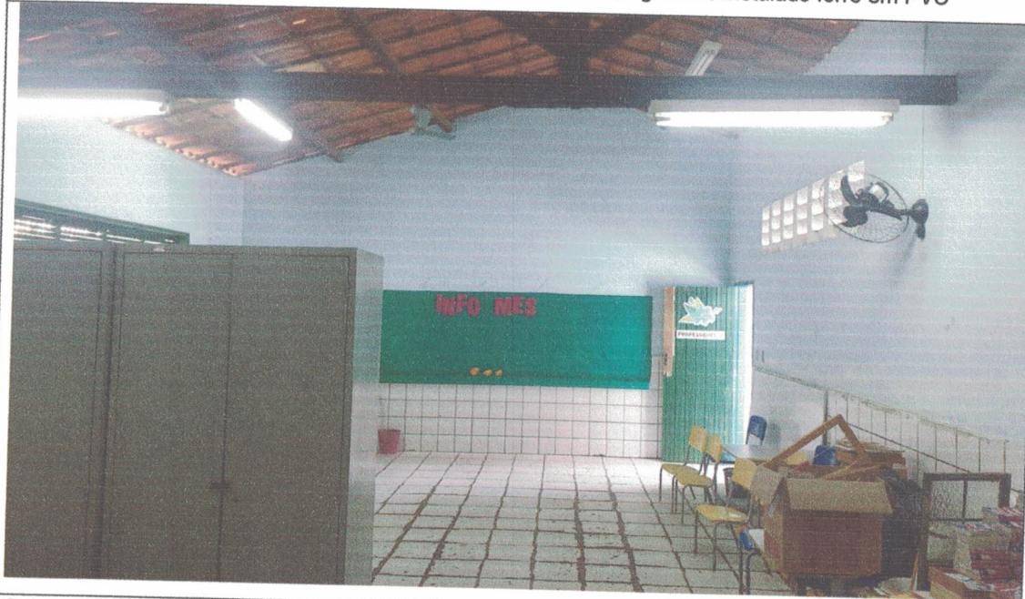
Sala de 3º e 4º ano – Local em que será construído divisória de gesso e instalado forro em PVC
