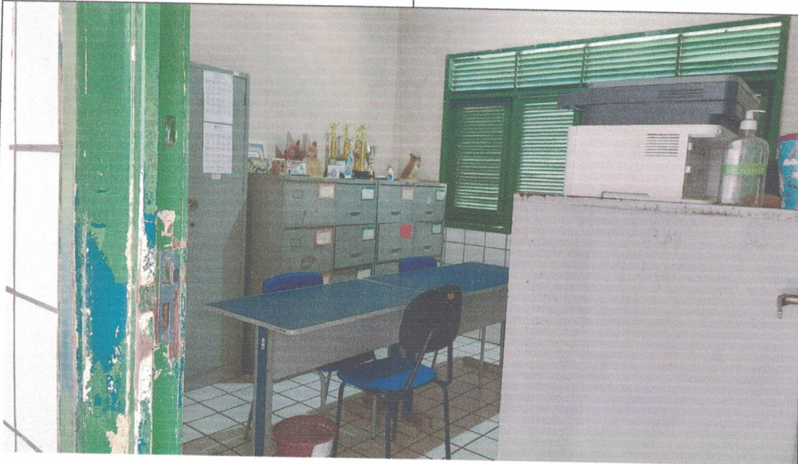
Sala da Secretaria – Local em que será instalado forro em PVC
