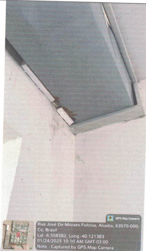
Calha metálica com desgaste aparente no CEI Professora Sirlene Maria do Nascimento
