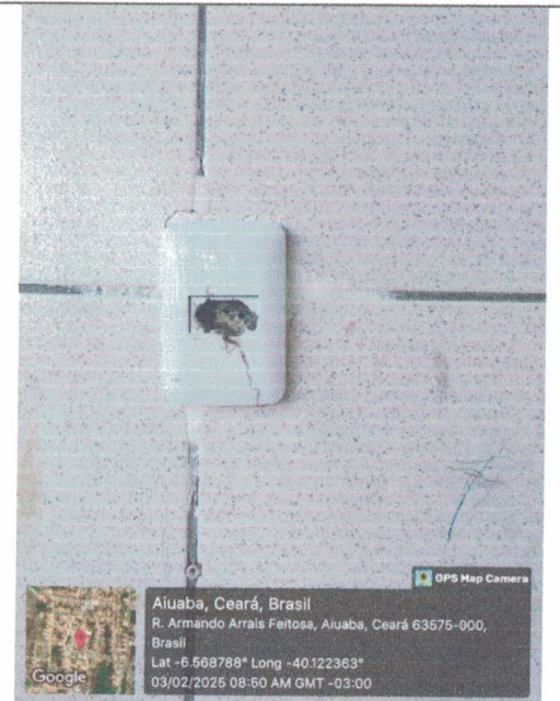
Pontos eletricos quebrados com risco de curto e choque eletrico no Centro Educacional Padre Pedro José
