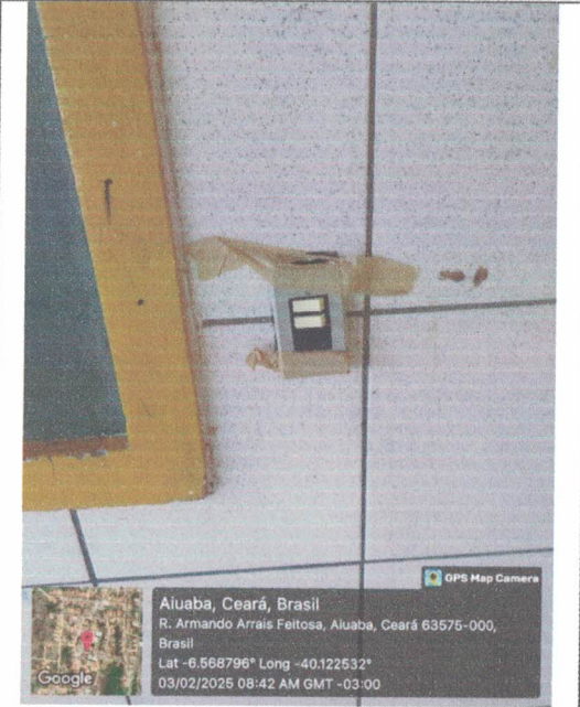
Pontos eletricos quebrados com risco de curto e choque eletrico no Centro Educacional Padre Pedro José
