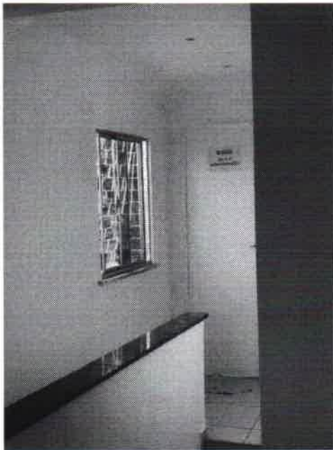
IMAGEM 04: PARTE INTERNA DO PRÉDIO. ENTRADA DA SALA DA ADMINISTRAÇÃO. FONTE: ACERVO PRÓPRIO
